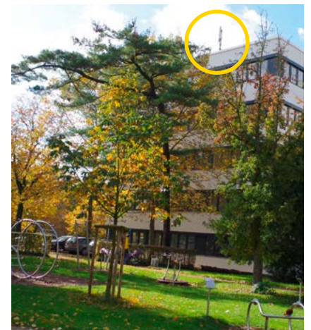
16.10.19, Göttingen, Campus, Sender auf Verfügungsgebäude, Kiefer
