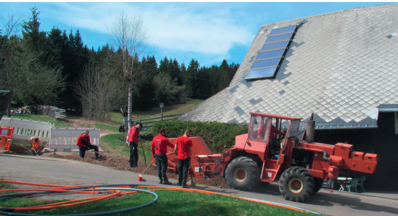
Glasfaser für jeden Bauernhof, das fordert diagnose:funk schon immer. Im Bild: Glasfaserverlegung im Weiler Balzhausen im Südschwarzwald.
