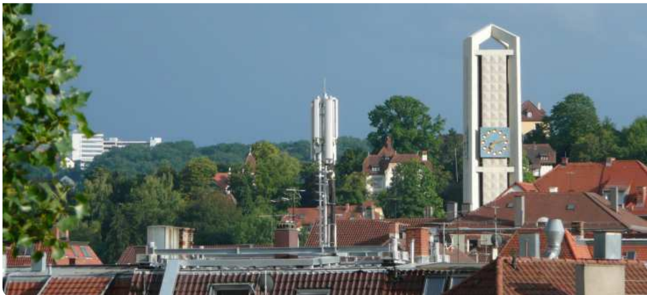
Sendemast im Wohngebiet - die optimale Lösung? Bild:diagnose:funk
