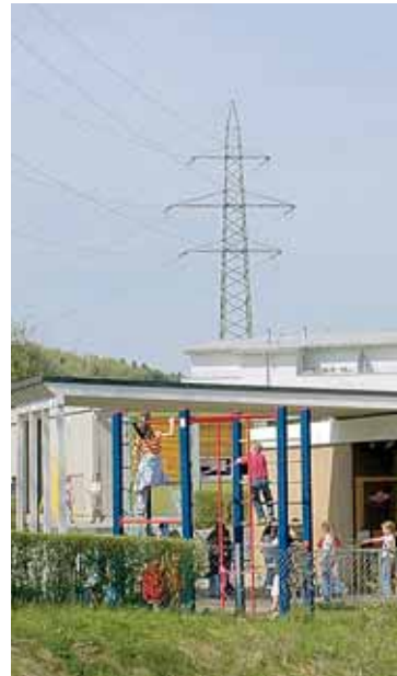
Dem Elektromog ausgesetzt: Schulpavillon in Winterthur
